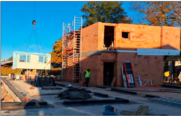
Instalace prvního panelu druhého pavilónu MŠ
