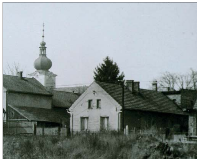
Foto č. 3: Dům čp. 149 (vpravo) v době výstavby základní školy
