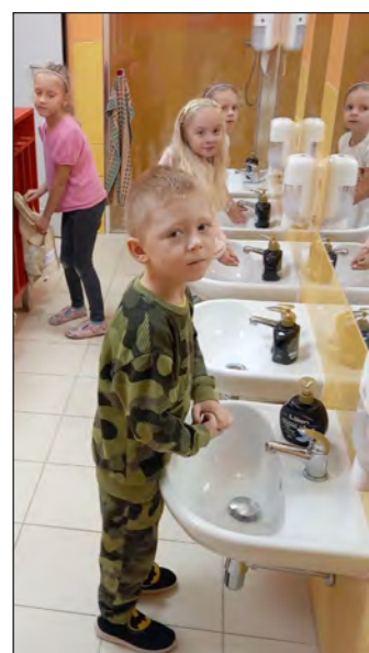
Nově zrekonstruovaná umývárna v nepasické školce
