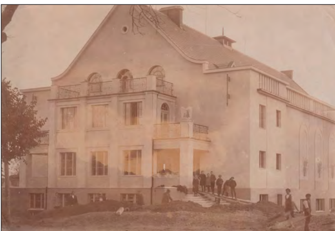
Terénní úpravy před dokončenou stavbou (č. p. 574)
