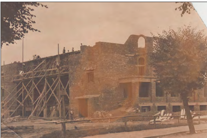
Stavební práce na budově sokolovny (č. p. 574)
