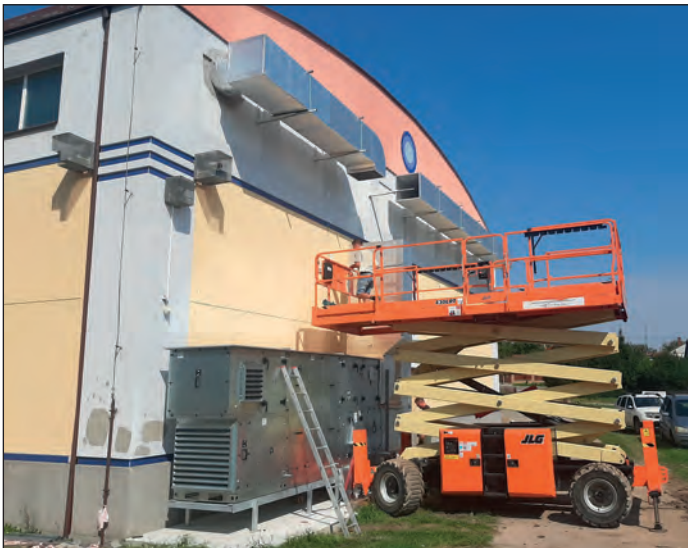
Dokončování venkovních rekuperačních rozvodů
