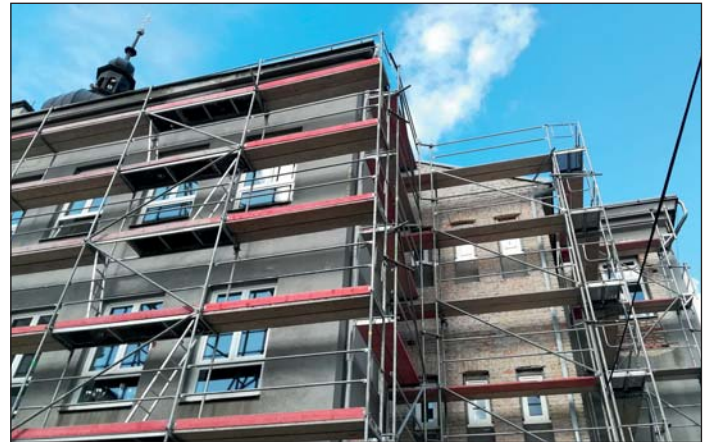
DDM - Pohled na východní stranu fasády, foto Otto Nosek
