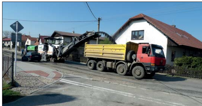
Oprava silnice v obci Ledce, autor: Miloš Čihák
