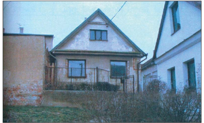
Dům čp. 394 v roce 2007 (před rekonstrukcí)
