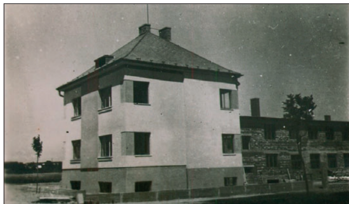
Pohled na stavbu domu čp. 874
